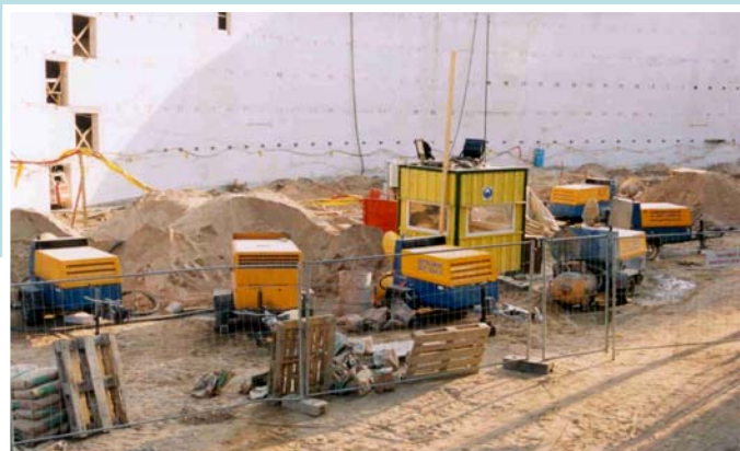
Großbaustelle mit UELZENER ESTROMAT Estrichmaschinen
